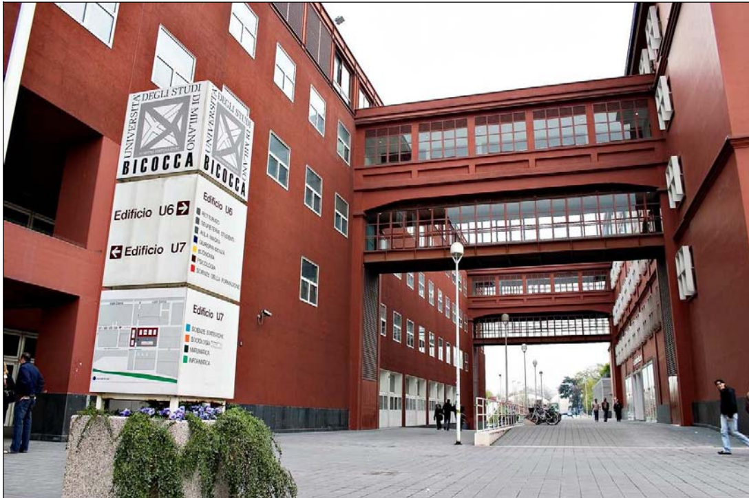
Ingresso dell'Edificio U7.
